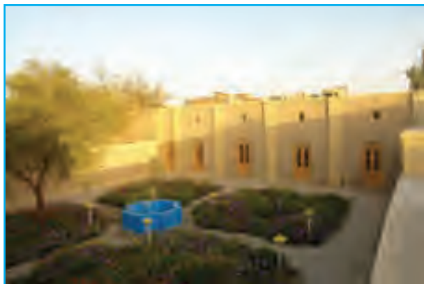
شکل ۱۰-۱۲- ساختمان بیت مقام معظم رهبری
