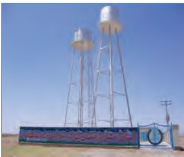
شکل ۱۰-۱۴- اجرای طرح آبرسانی بهداشتی روستایی
