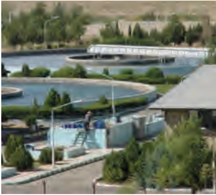
شکل ۱-۳۲- تصفیه‌خانه سد ۱۵ خرداد
