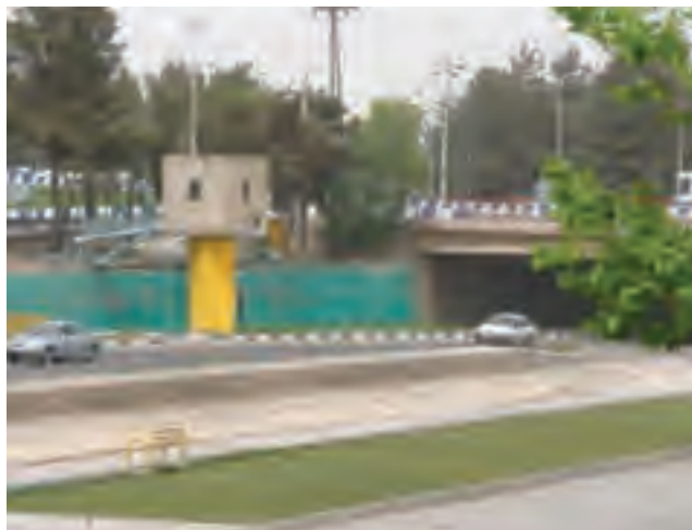
شکل ۱۸-۱- تصویر یکی از چاه‌های آب داخل رودخانه
