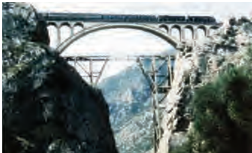
شکل ۲۸-۵- راه آهن شمال - پل ورسک
