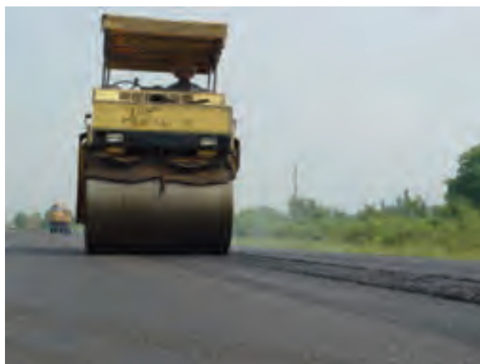
شکل ۴-۶- عملیات راه سازی
