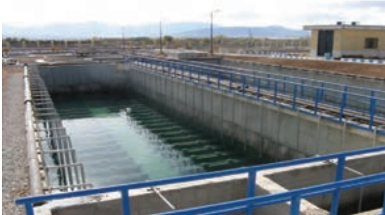
تصویر ۱-۵- تصفیه خانه شهرک صنعتی شهرکرد
