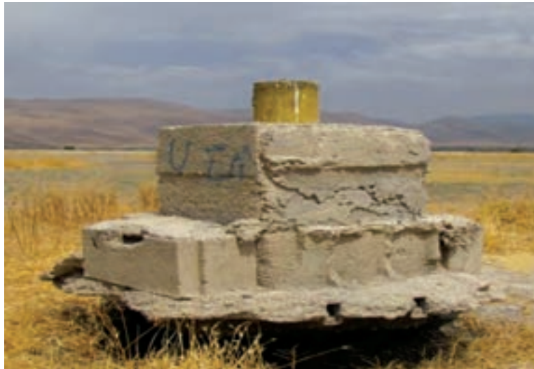
تصویر ۸-۴- پدیده فرونشست زمین (منطقه خانمیرزا)
