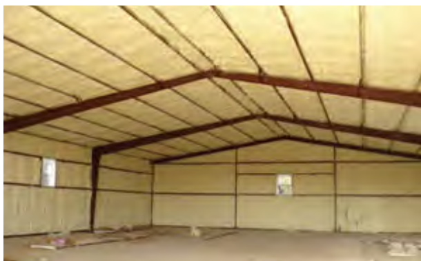
عایق‌بندی سقف و دیواره
