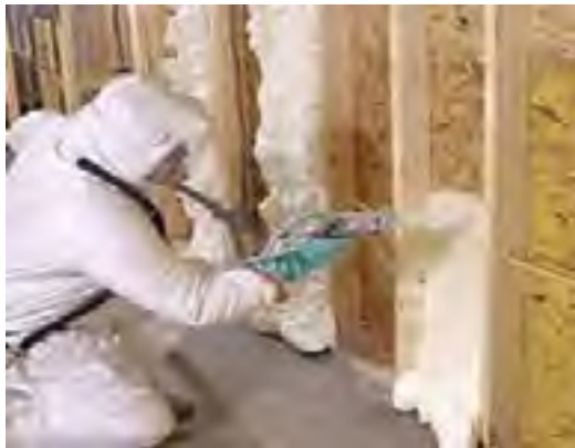
عایق‌بندی با نوعی فوم خمیری
