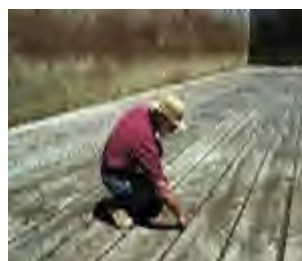
هوادهی قالب ها برای خشک شدن
