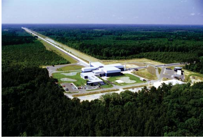
شکل ۱۶-۶: آشکارساز موج گرانشی لیگو. دو بازوی عمود بر هم را می بینید.
